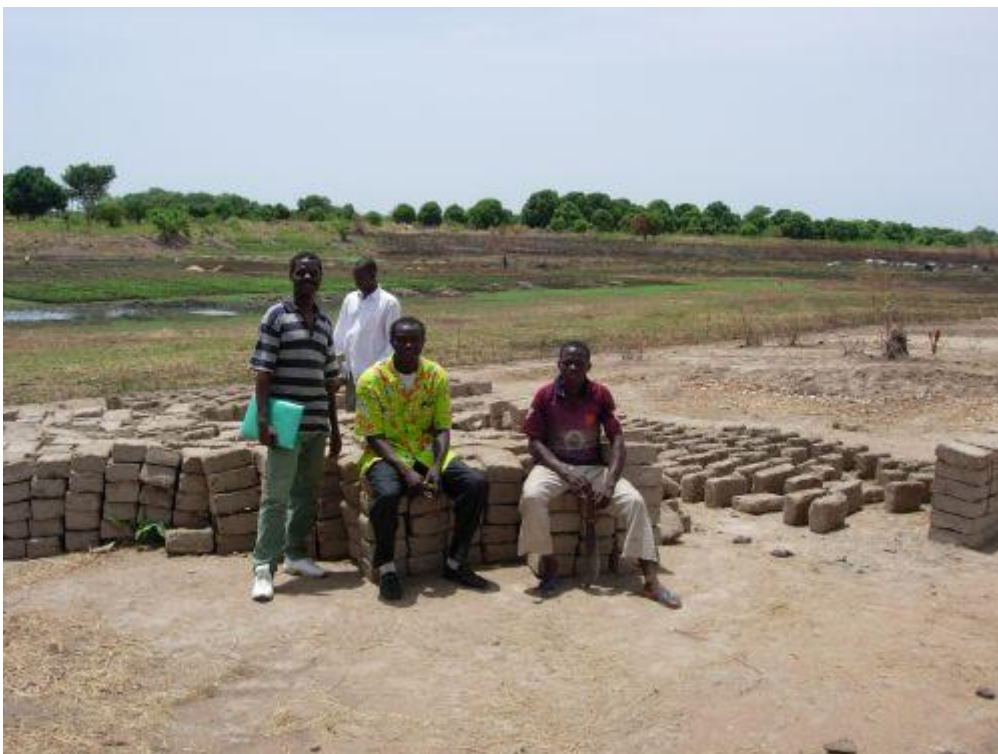
Illustration 3: quelques membres de GLB posent devant les briques qui serviront à construire la case du gardien. A gauche, le pasteur Enoch, fondateur du groupement. A droite, le jeune qui viendra s'installer sur le terrain en compagnie de sa femme. Les briques ont été fabriquées par un groupement de jeunes à partir de l'argile ramassé sur le cours d'eau en arrière fond, à sec durant la saison sèche. On aperçoit quelques parcelles de maraîchage.
